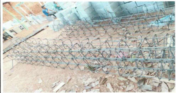
Foto 2: Preparación de soporte
