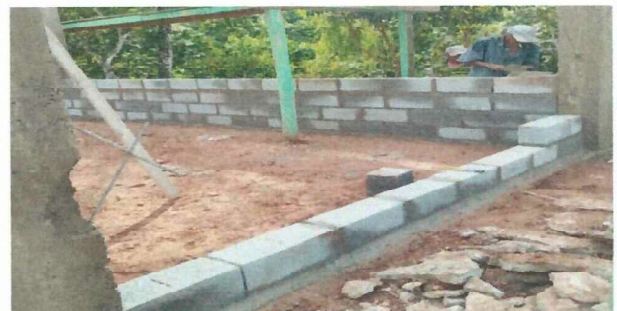
Foto 4: Sustitución de pared y colocación de block
