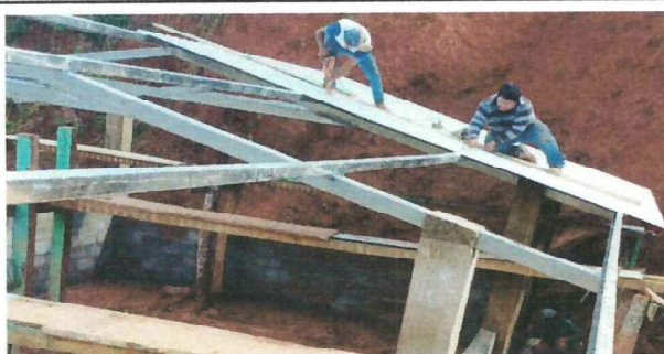
Foto 5: Sustitución de techo
