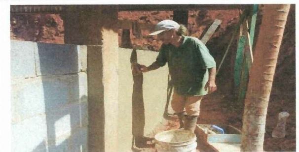
Foto 6: Colocación de repello
